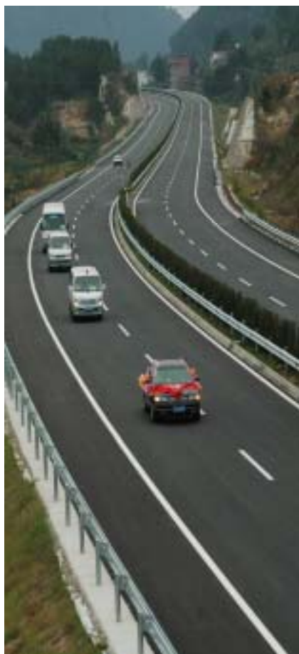
公司投资修建的徽杭高速公路（安徽段）
